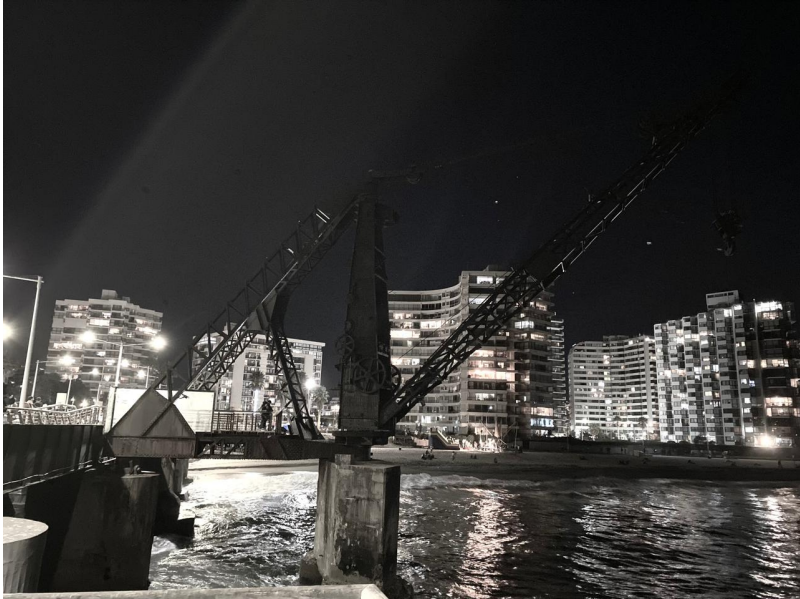
Figura 2: Grúa accionada por carbón, para descargar carbón, para el circuito CRAV, COLUN, Gasómetro y otros
