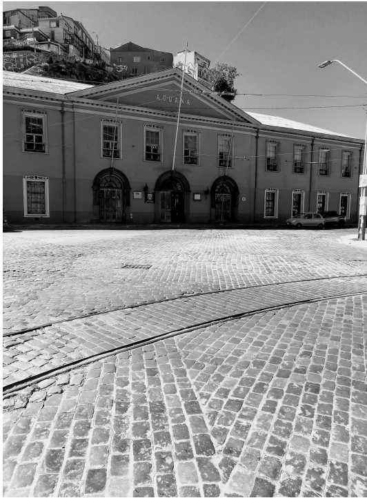
Figura 5: Adoquines de lastre, riel de tranvía y al fondo, Aduana de fachada inglesa
